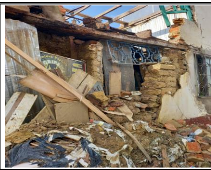
VISTA DEMOLICION CASA VECINA
