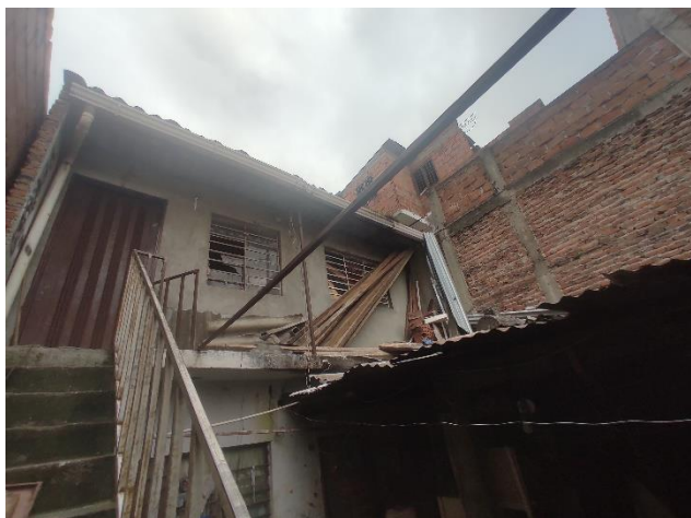
CONSTRUCCION POSTERIOR DE 2 PISOS
