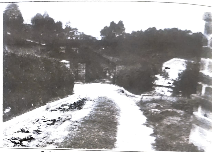
CARRETEABLE DE ACCESO
