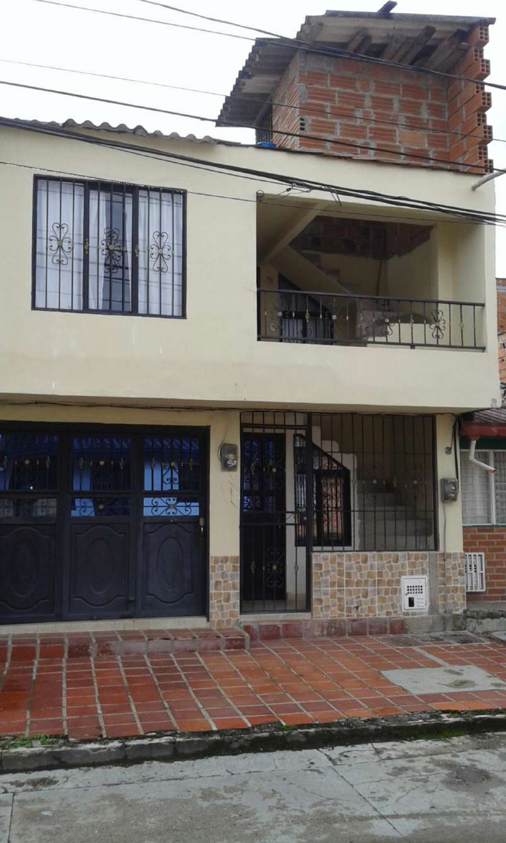
CASA DE VIVIENDA MILITAR CRA 74 # 42-24 CUARTA ETAPA, BARRIO EL PORVENIR, RIONEGRO
