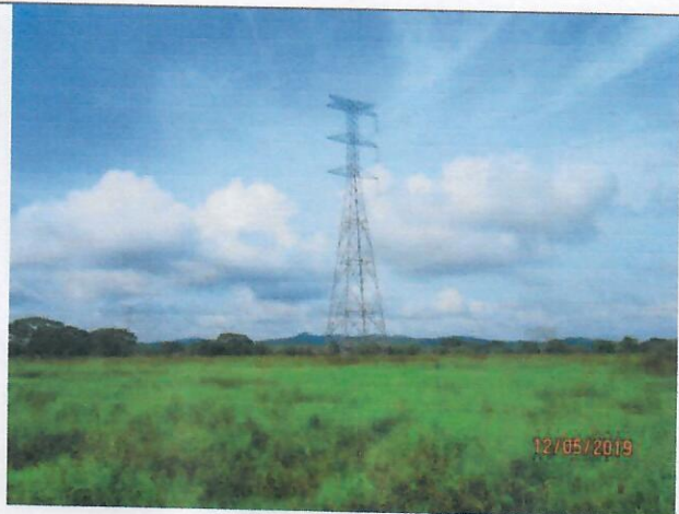
VISTA DE LAS CUERDAS QUE CONSTITUYEN LA SERVIDUMBRE DE ENERGIA ELECTRICA
