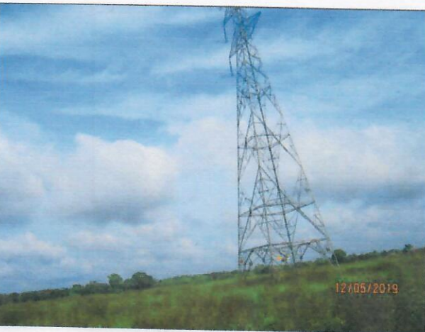
VISTA DE UNA DE LAS TORRES QUE HACEN PARTE DE LA SERVIDUMBRE ELECTRICA
