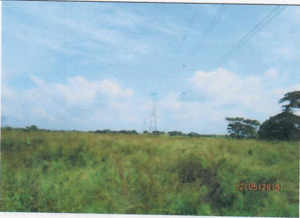
VISTA GENERAL DE LA FRANJA DE SERVIDUMBRE ELECTRICA.
