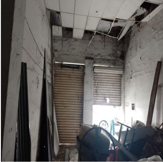
VISTA DE ADENTRO HACIA LA ENTRADA PRINCIPAL
