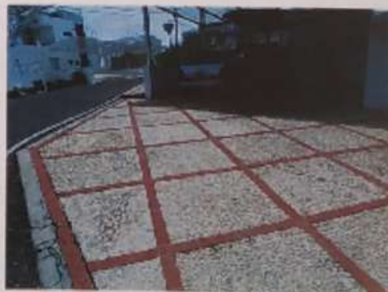
DETALLE PISO DE PARQUEADERO
