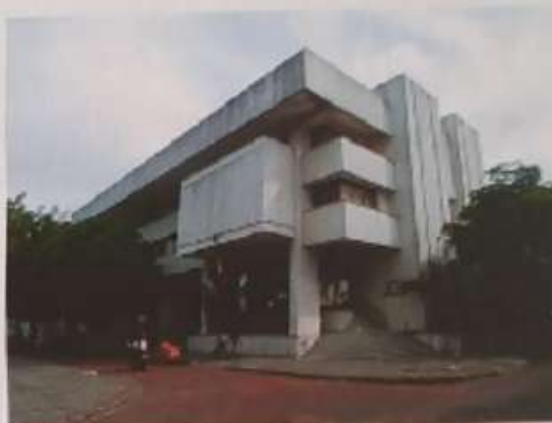
EDIFICIO BANCO DE LA REPÚBLICA
