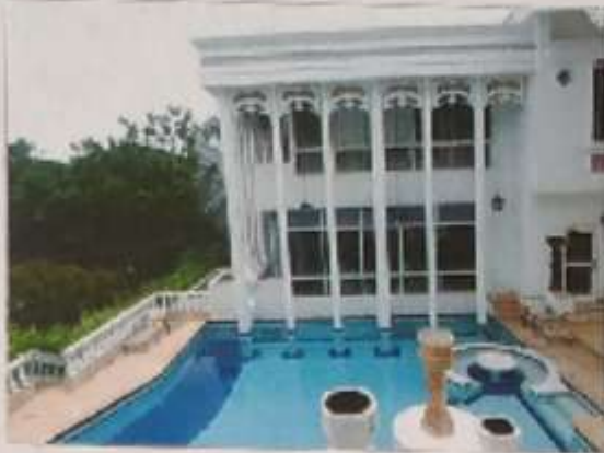
FACHADA SOBRE PISCINA
