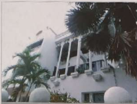
DETALLE DE FACHADA
