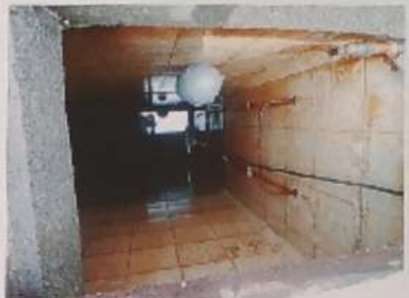
INTERIOR DE TANQUE
