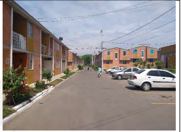
VIA DE ACCESO INTERNA
