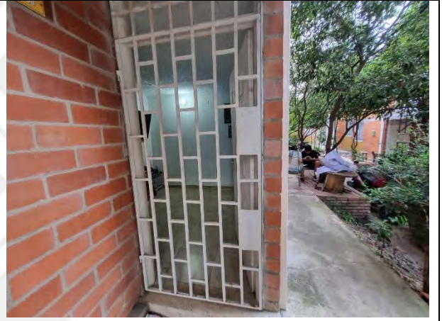
PUERTA DE ACCESO PPAL
