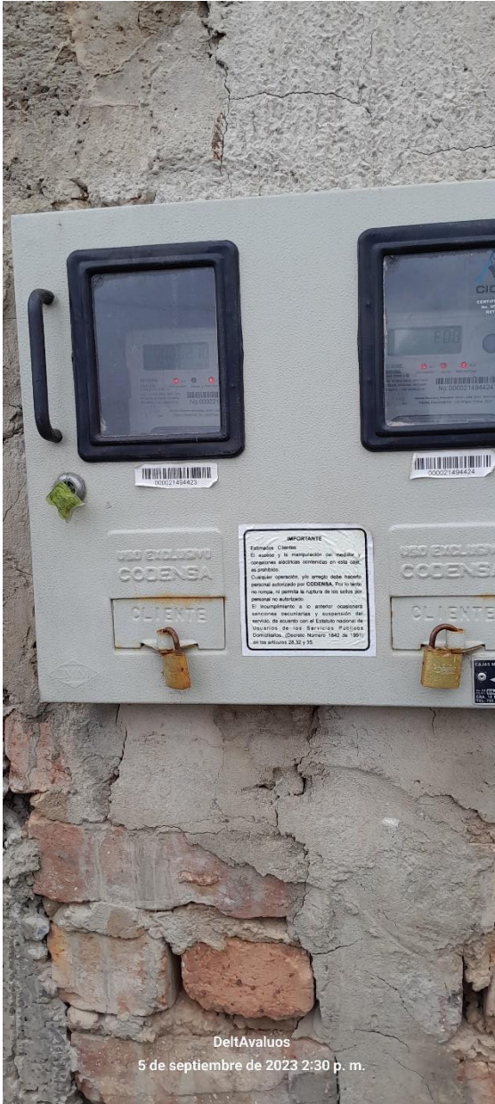
Medidores de energía eléctrica y gas natural.
