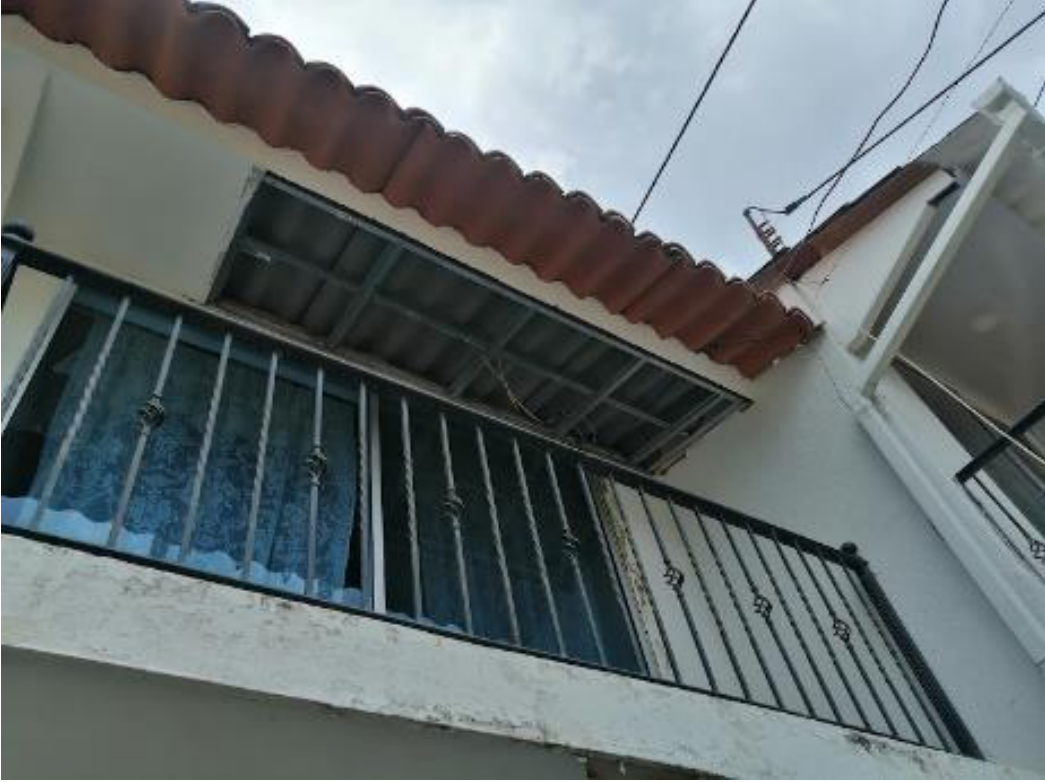
Detalles cielo raso
