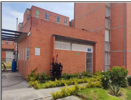
CUARTO DE BASURAS - ZONA COMÚN
