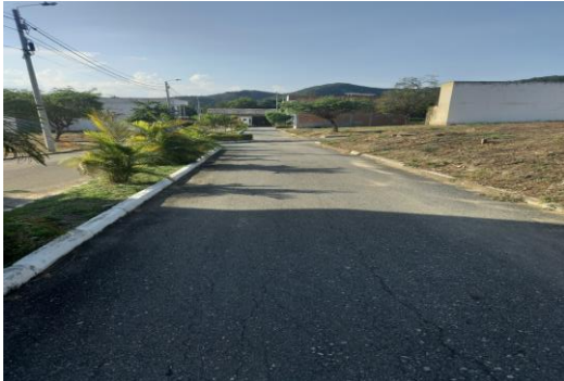
Acceso interno Condominio
