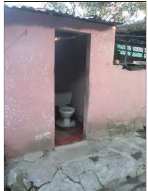
ESTADO INTERNO BAÑO
