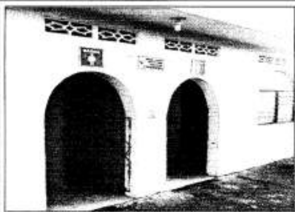
BAÑOS Y VESTIERES PISCINA
