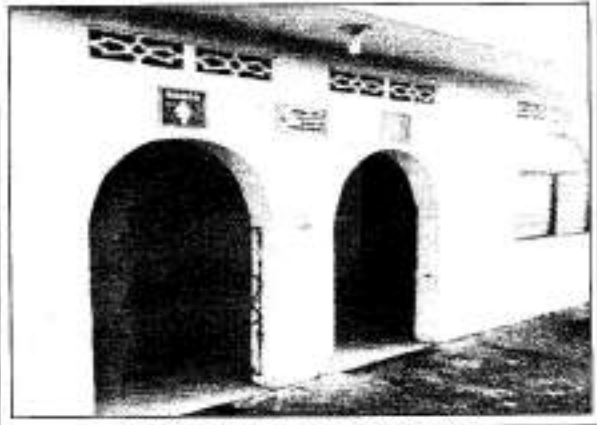
BAÑOS Y VESTIERES PISCINA
