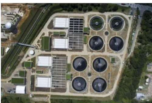
LA PTAR ESTÁ UBICADA EN LA VÍA PRINCIPAL QUE DEL MUNICIPIO DE BELLO CONDUCE A COPACABANA, GIRARDOTA Y BARBOSA. TRATA LAS AGUAS RESIDUALES DEL NORTE DEL VALLE DE ABURRÁ. FOTO JUAN DAVID ÚSUGA
