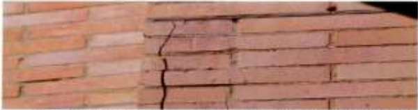
Fotografía No.61. Detalle agrietamiento fachada.
