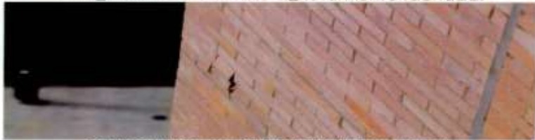
Fotografía No. 62. Abombamiento chapas.
