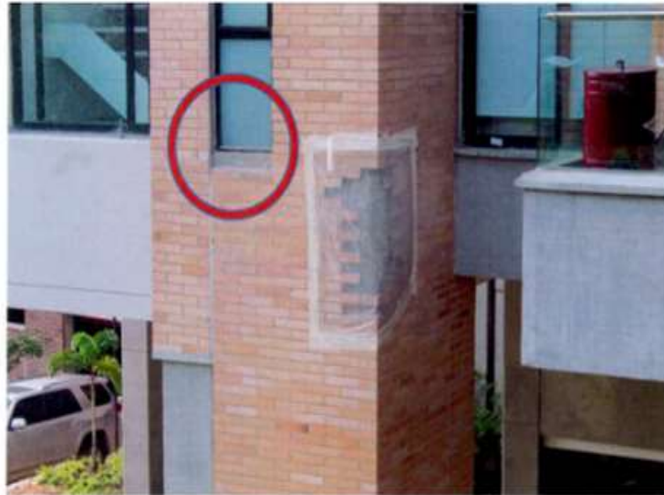
Fotografía No.82. Deterioro de chapas a nivel de losa, pendiente reparación en momento de revisión. Ventana pequeña sin sillar de concreto.
