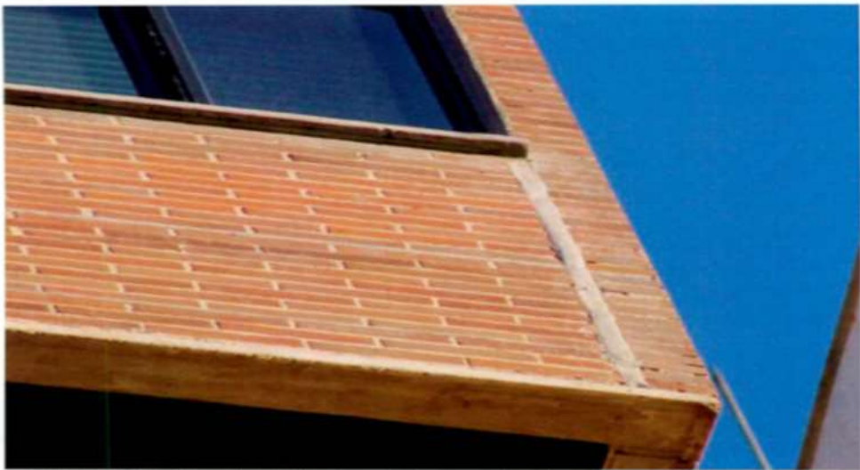
Fotografía No.73. Detalle falta de rebites, mal sellamiento y falta de acabados en ventanería..
