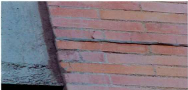
Fotografía No.72. Detalle abombamiento en chapas.
