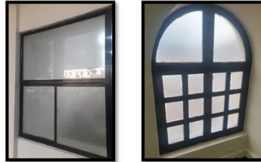
MANTENIMIENTO PREVENTIVO Y CORRECTIVO DE LA INFRAESTRUCTURA DE VENTANAS Y PUERTAS DEL PALACIO NACIONAL FRANCISCO DE PAULA SANTANDER Y PALACIO DE JUSTICIA LUIS CARLOS PÉREZ ($83.518.416)
