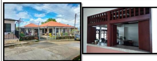
MANTENIMIENTO Y MEJORAMIENTO DE LA INFRAESTRUCTURA FÍSICA EN LOS PALACIOS DE JUSTICIA DEL TAMBO, EL BORDO-PATÍA, CORINTO, PUERTO TEJADA, GUAPI, SANTANDER DE QUILICHAO Y EN LOS JUZGADOS DE RESPONSABILIDAD PENAL PARA ADOLESCENTES EN POPAYÁN ($1.635.665.727)
