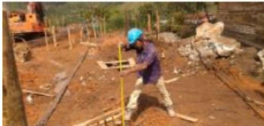
Toma de niveles para vaciado de concreto
